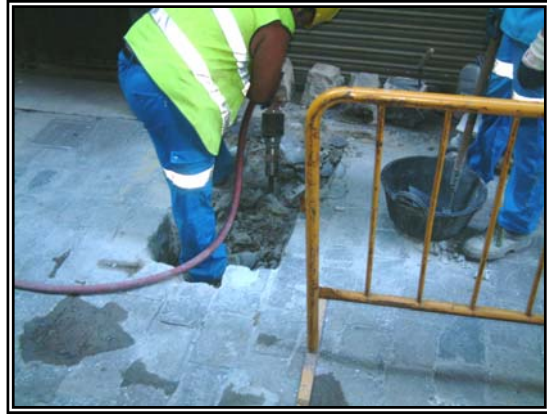
Imatge de detall de l'aixecament de les llambordes que formen la UE 101
