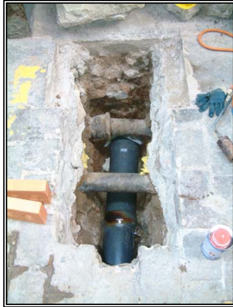
Vista general de la finalització de l'obra. En aquesta es pot observar la configuració del nou ramal de la claveguera central del carrer
